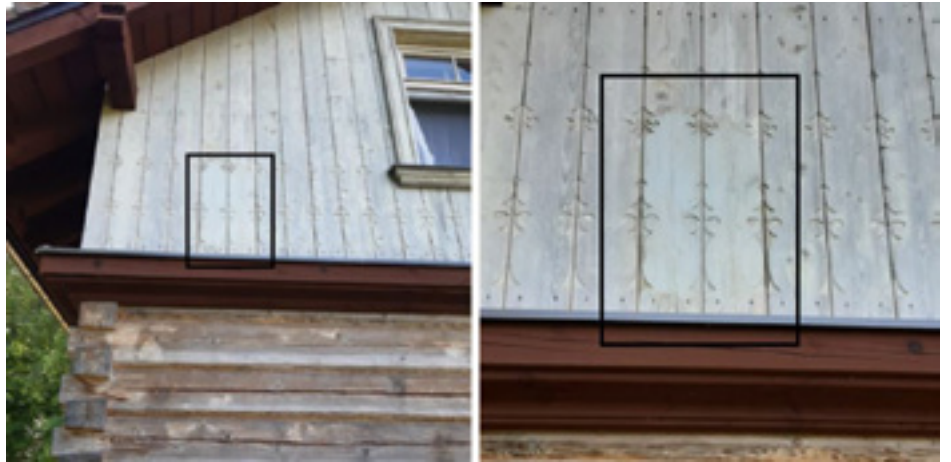
Abb. 9 // Demonstrationsobjekt C (Restaurierung) nach zwei Jahren der Exposition; die gekennzeichnete Fläche wurde mit Farbe für historische Restaurierungen mit einem Zusatz von 4 % Additiv gestrichen.
